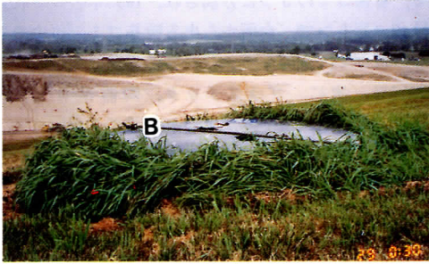
図 3 B ゴミの山頂の集水塔
