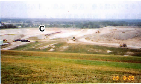
図 3 C 作業中の埋立地
