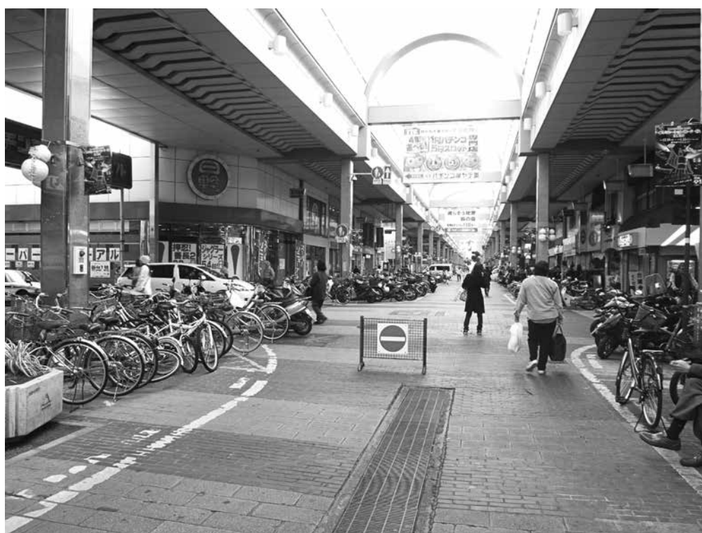
写真-6 街路の中央に配置された排水溝と排水溝を覆うグレーチング
