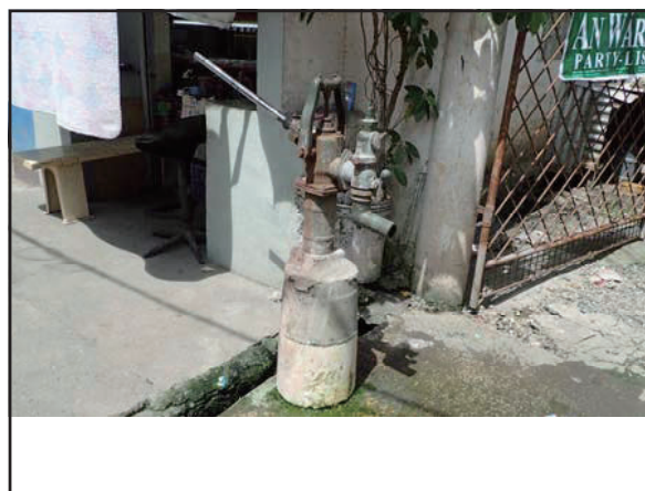
写真4 タクロバン市中のポンプ付き管井戸の一例 2019年現在
