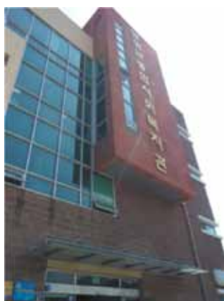
写真22 楊平郡総合社会福祉館
