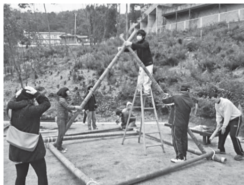
写真4 土台の四角形を作り、「くの字」型の竹を立てる
