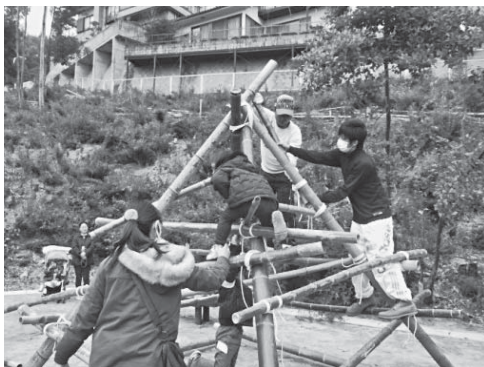
写真8 完成間近のジャングルジム
