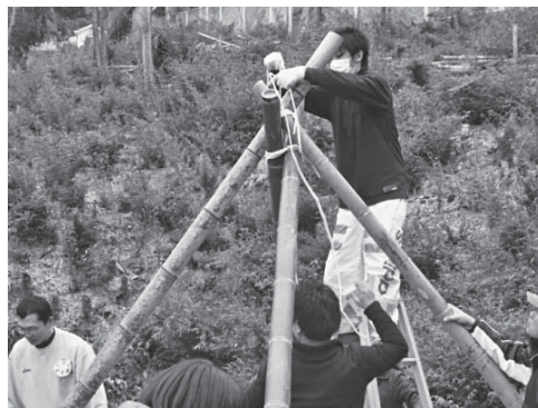
写真5 「くの字」型を2組使い、ピラミッド状にする
