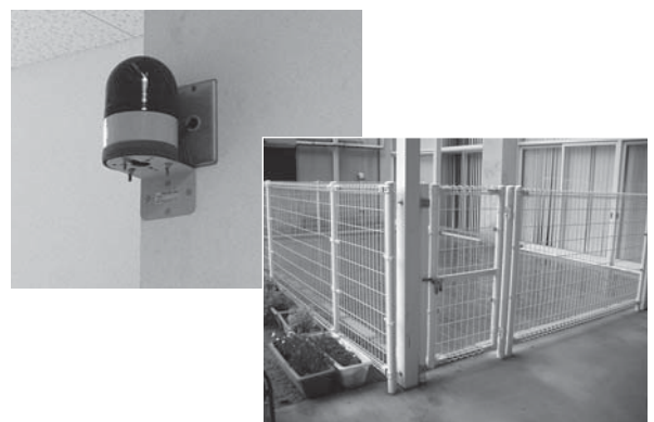
写真3 緊急事態へ対応するための設備(赤色灯、扉)
